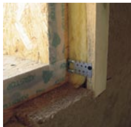
Obr. 4 Detaily prerušenia tepelných mostov v tepelnoizolačnej obálke stavby
