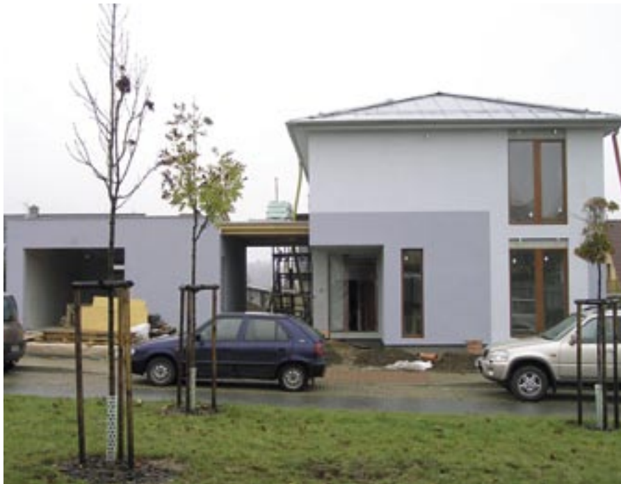
Obr. 2 Objekt vo fáze realizácie – stav k 10/2008
