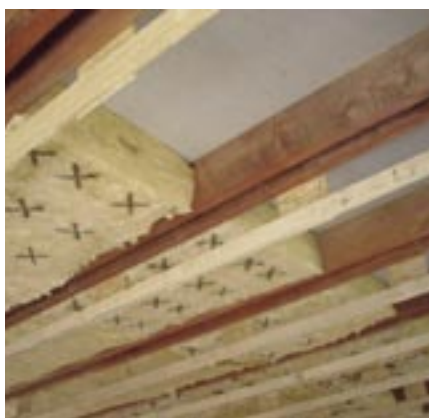
Obr. 4 Detaily prerušenia tepelných mostov v tepelnoizolačnej obálke stavby
