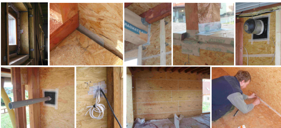
Obr. 5 Detaily zajištění těsnosti vzduchotěsné a parotěsné vrstvy.
