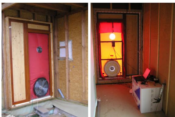
Obr. 3 Kontrola vzduchotěsnosti stavby – Blower Door Test, 08/2008, Ing. Jiří Novák, Ph.D., Fakulta stavební ČVUT v Praze.
